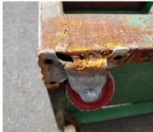
바퀴 설치 상태
