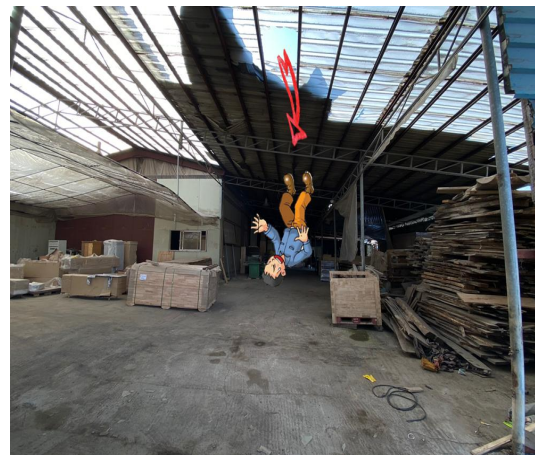
채광창 위에 방수포를 밟고 넘어진 후 채광창이 파손되며 추락
